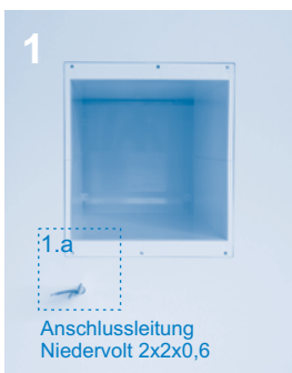
Wand-Teleskopeinheit und Netzanschluss sind vorbereitet
