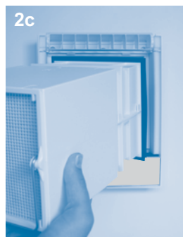
Systemträger in die Wand einschieben
