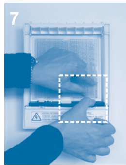
7 Systemträger in die Wand einschieben
